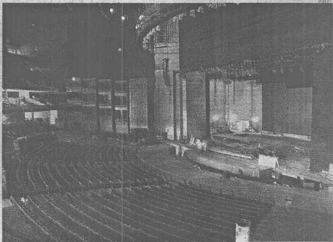
Las obras en el Auditorio Metropolitano "están a 99 por ciento de avance", asegura el funcionario universitario
