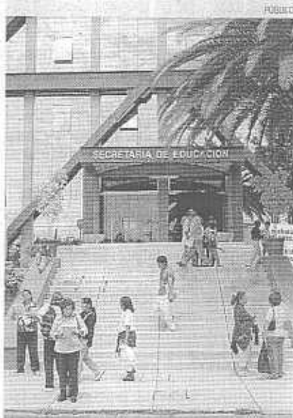
Fachada de la torre de Educación , por si algún lector necesita una referencia física.
