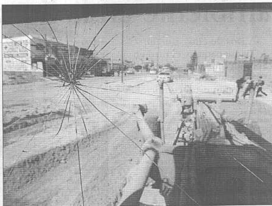
• EL INFORMADOR llevó a cabo un recorrido en cuatro puntos, donde el Ayuntamiento de Tonalá realizaría trabajos de mejora en la infraestructura de calles, banquetas, sistema de agua y drenaje.
