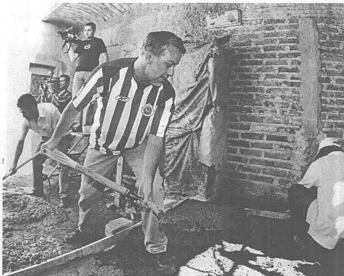
MEZCLA AFICIÓN CON TRABAJO. El Gobernador Emilio González Márquez hizo labores de albañilería en varias casas, en Tlajomulco de Zúñiga, como parte del programa "Mejora Tu Casa". Paleó, cargó botes y se ensució. Hubo quien le gritó varias veces "¡arriba el Atlas!", y él respondió con una invitación a ayudar en lugar de gritar.
