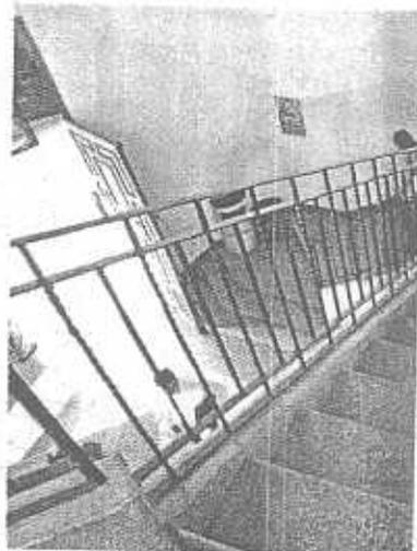
**JUNTA LOCAL DE CONCILIACIÓN Y ARBITRAJE.** Cuatro de siete extintores colocados a la (izq.) no tienen carga. Además, las escaleras no tienen pasamanos en ambos lados, como indica la norma.
