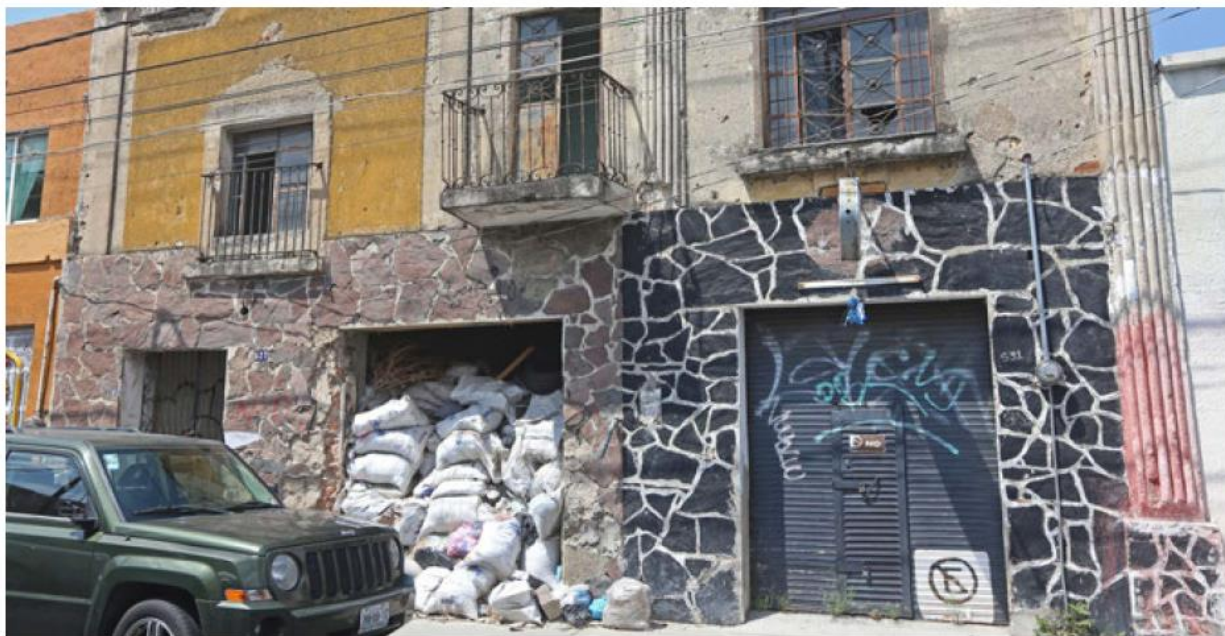
Realizan censo de las viviendas que están abandonadas en la Perla Tapatía. FERNANDO CARRANZA
