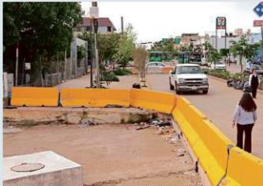
■ En la zona no se ve avance en los trabajos de rehabilitación.
