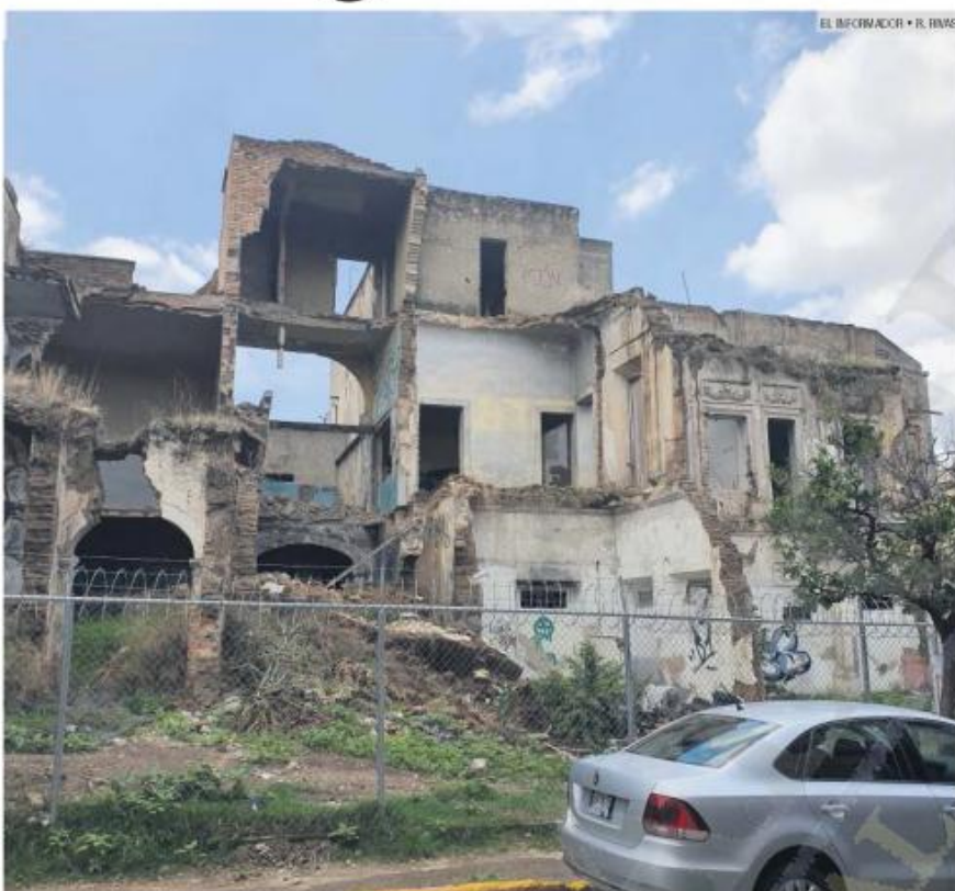
FUTURA SEDE. Ruinas del terreno de José Luis Baruqui, donde se pretende construir el inmueble.
