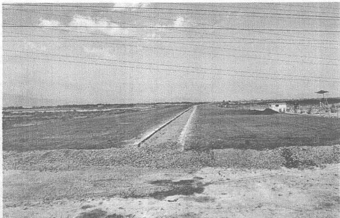
► El Gobernador Emilio González Márquez informó que ya se adquirieron los terrenos del tramo 3 para completar el Anillo Periférico, obra que lleva casi 50 años inconclusa y en la que se trabaja desde la anterior Administración.
