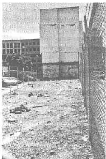
► Tras el derribo de fincas, los terrenos aledaños al Parque Morelos esperan el inicio de las obras.
