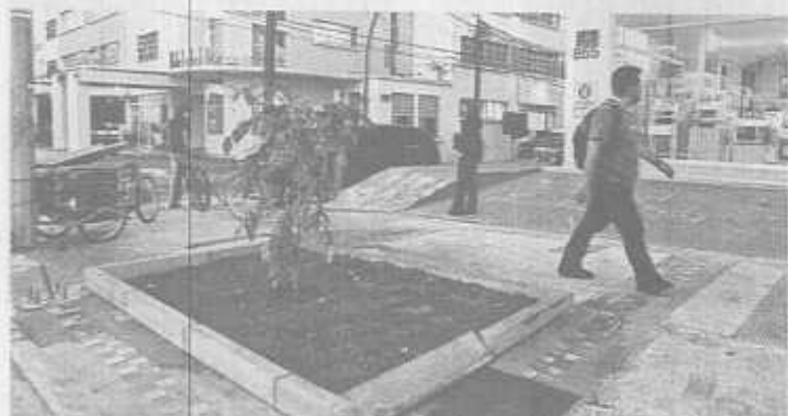
Además de las fallas en banquetas, en otras se levantaron jardineras que obstruyen el estacionamiento como la de Juárez y Camarena.
