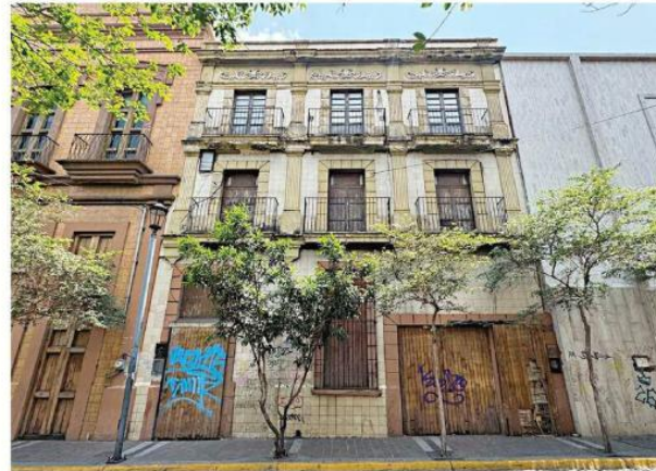
Esta fachada colindante con el edificio en el Centro de la Ciudad deberá preservarse como parte del proyecto de construcción.
