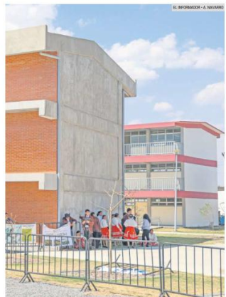
INFRAESTRUCTURA. Instalaciones del nuevo Bachillerato Nacional inaugurado en El Salto, parte del programa federal para ampliar la educación media superior.
