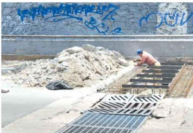
CAOS VIAL. Las obras en Lázaro Cárdenas y carretera a Chapala generan tráfico en la zona.
