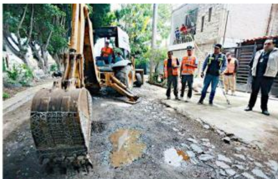
■ En Los Gavilanes Oriente se rehabilita la Calle Hidalgo, en el tramo de La Soledad a López Mateos.
