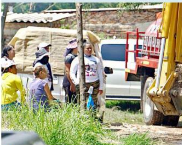
Los trabajos en La Ladrillera continuaron ayer.
