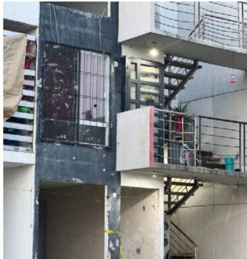
Disparó contra la ventana en el segundo piso. USI TOLEDO
