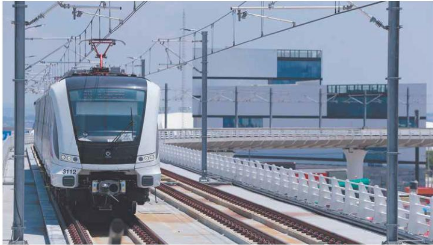
EN ZAPOPAN. La anterior administración planteó crecer la L3 hasta Tesistán. Actualmente termina su trazo en Arcos de Zapopan.
