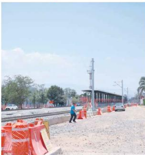
LO ÚLTIMO QUE SE SABE. Las obras de la línea 4 tienen un avance general de 89 por ciento, según la administración estatal.
