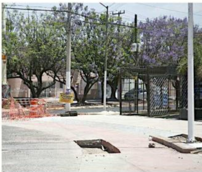
En la zona se realizaron trabajos previos durante 2024.
