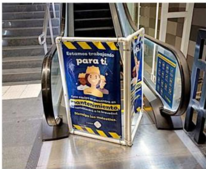
■ En Guadalajara Centro dos escaleras llevan un mes sin servicio.
