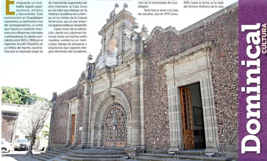
Los muros externos de la Casa Zuno son de tezontle, material proveniente de los alrededores del Volcán de Tequila.
