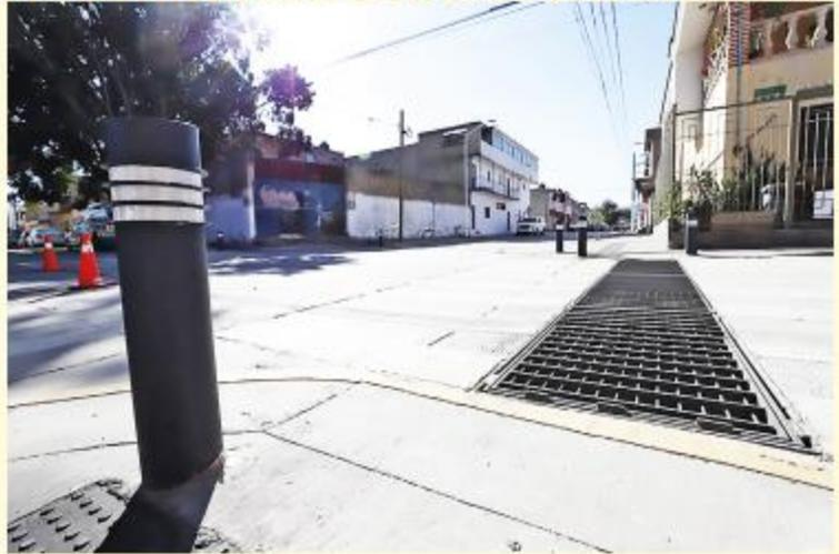
Se rehabilitaron un total de 360 metros cuadrados con concreto hidráulico de las calles Puerto Topolobampo, Salina Cruz y Brisa Marina, dicha intervención consistió en la renovación de líneas de agua potable y drenaje sanitario con sus respectivas tomas domiciliarias y descargas sanitarias, pavimentación con concreto hidráulico, banquetas incluyentes, cruceros seguros, alumbrado público, señalética horizontal y vertical, así como su respectiva forestación.
