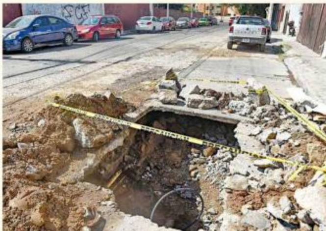
El colapso del pavimento fue a consecuencia de una fuga.
