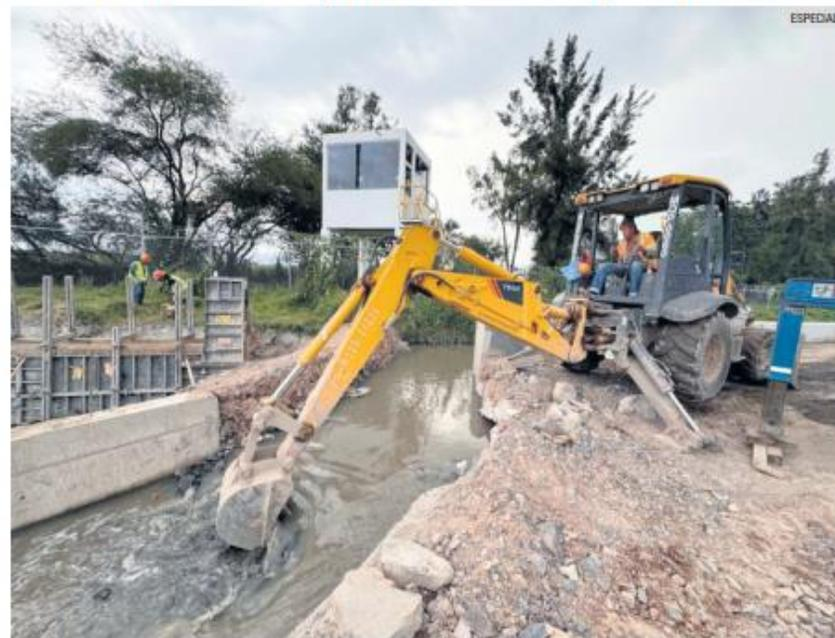
El Gobierno de Tlajomulco trabaja en el desazolve de un canal pluvial para mitigar inundaciones en Adolf Horn, a la altura del paso a desnivel.
