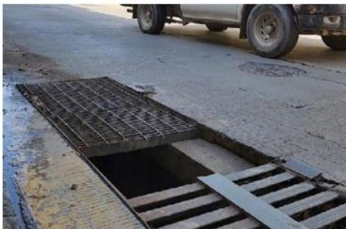
**FEDERALISMO.** Alcantarilla dañada en el paso a desnivel cerca de Periférico causó riesgo a los vehículos. La falta de protección y daños provocados por ladrones generó problemas.
