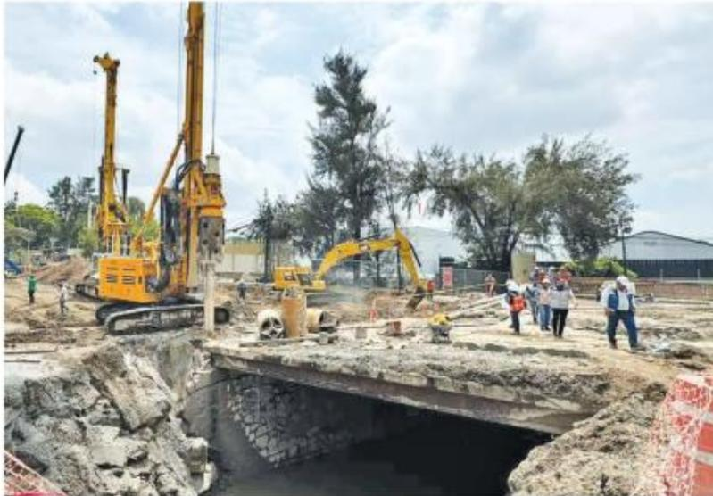
La construcción del puente de Avenida López Mateos registra 58 de 62 pilas perforadas y coladas. Este lunes se prevé que ya estén instaladas completamente, lo que permitirá trabajar sobre los pilotes y finalmente instalar las traveses. Se inyectaron 80 millones de pesos a esta obra para resolver los efectos del socavón que ha desquiciado la vialidad urbana
