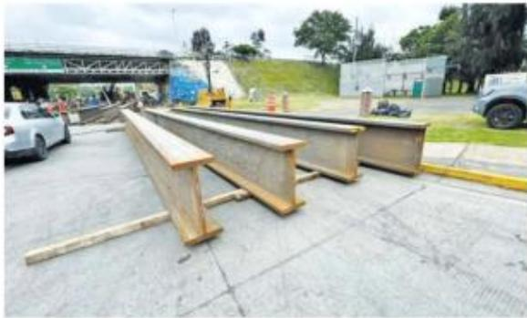
Arrancó la demolición de la losa existente del puente que colapsó, lo que permitirá que se inicie con la sustitución del colector sanitario en el lecho del arroyo. Ya se tienen seis vigas de acero totalmente terminadas y aprobadas con las pruebas químicas y radiografías.
