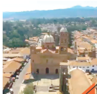
Desde infraestructura deportiva, calles, rehabilitación y mantenimiento de carreteras.
