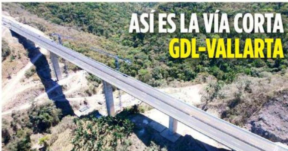
■ El puente "Las Truchas" tiene una longitud de 433 metros y una elevación de 75 metros, y une la autopista Jala-Compostela-Las Varas.
