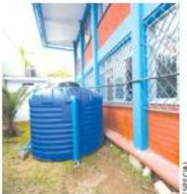
**CAPACIDAD.** Con el sistema instalado en la primaria se podrán captar hasta 350 mil litros pluviales.
