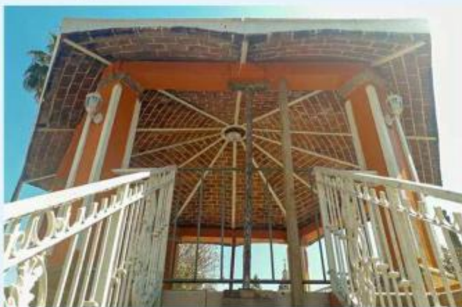
■ El Ayuntamiento informa que los trabajos iniciaron el martes.
