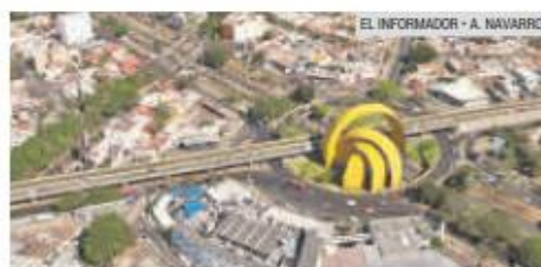
EMBLEMÁTICA. Además de la planeación y obras de Luis Barragán, destacan los Arcos del Milenio.
