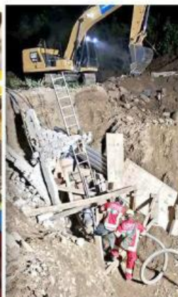
■ En la zona se hicieron trabajos de reforzamiento.
