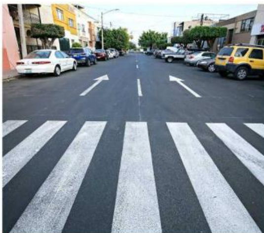
■ Esta fue una de las vialidades rehabilitadas de la Col. Morelos.
