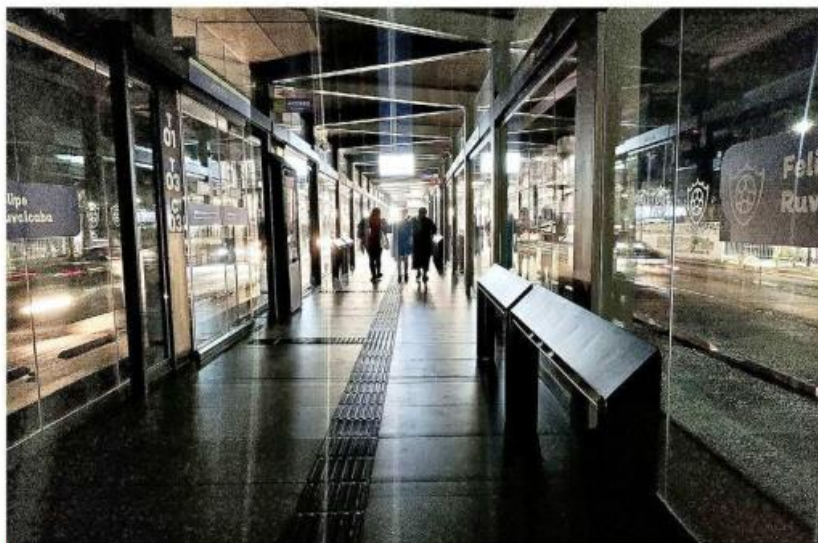
En la Estación Felipe Ruvalcaba hay fallas en la luz del interior.
