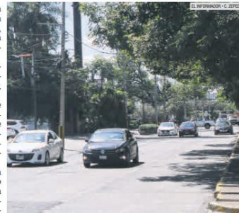
SOLICITUD. Personas que viven cerca de la Avenida Pablo Neruda pidieron que los trabajos hagan que la vía se mantenga en buen estado a largo plazo.
