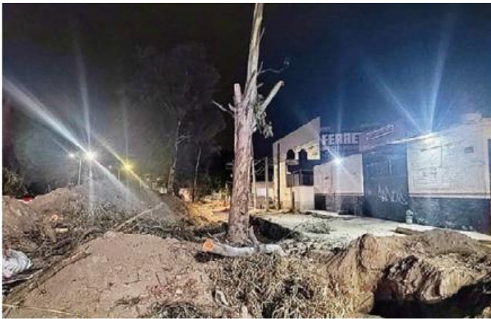
ECOCIDIO. Decenas de árboles, principalmente eucaliptos, ubicados en Periférico Poniente, fueron talados por el personal de la Secretaría de Infraestructura y Obra Pública de Jalisco.
