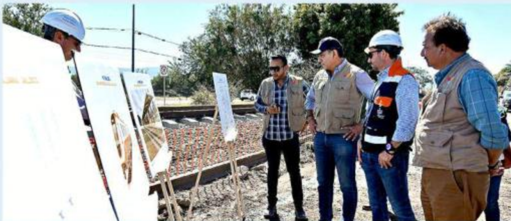
■ Funcionarios municipales y estatales supervisaron la obra.
