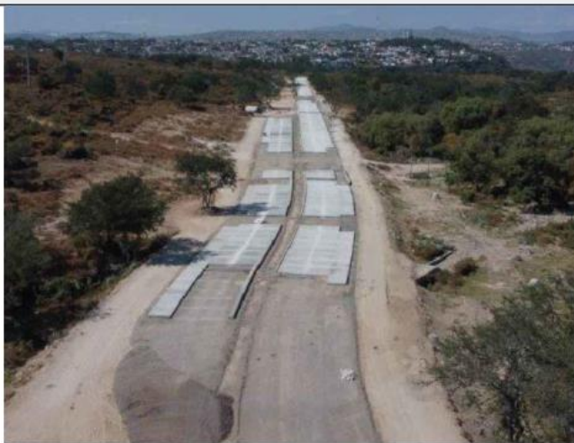
Pablo Lemus precisa que Operadora Hotelera Salamanca, que ahora tiene la posesión del premio, si han ejecutado las obras de contraprestación, como la avenida central que tiene un avance del 70%.
