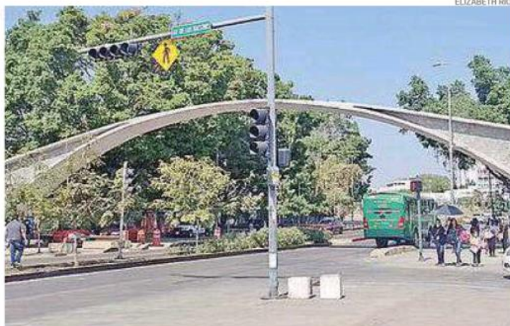
No hay daños estructurales en el puente.
