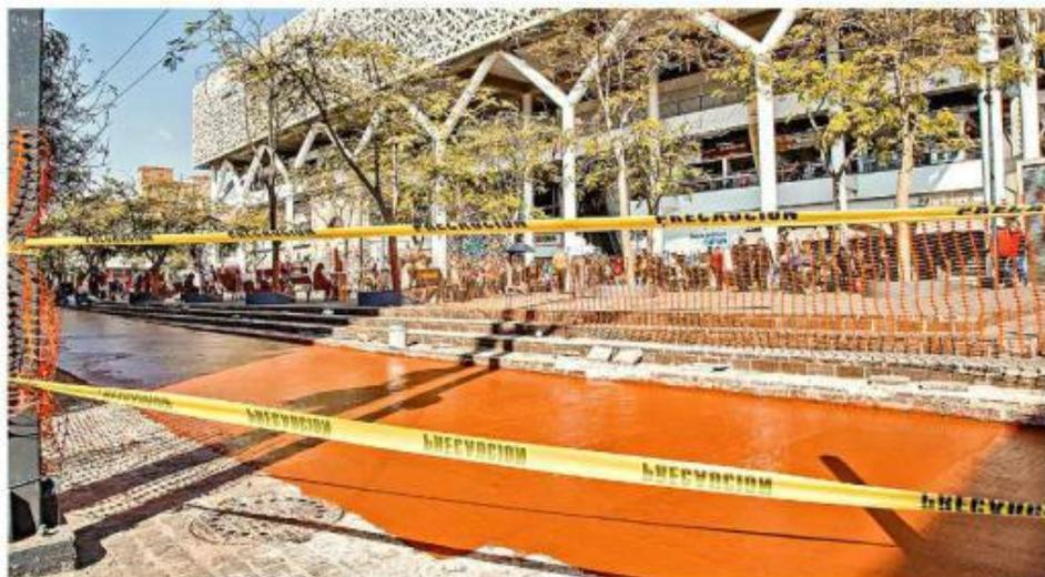
Al carril exclusivo se le retiró el adoquín pórfido y será sustituido por concreto estampado.
