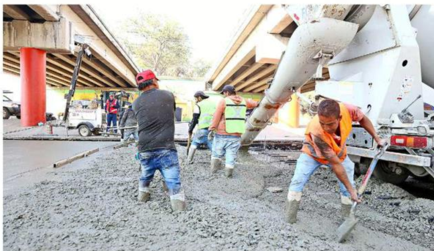
■ Para evitar baches, el asfalto en Lázaro Cárdenas se sustituye por concreto hidráulico.
