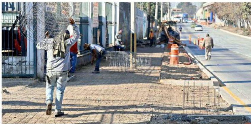
■ También realizan trabajos de renovación de banquetas.
