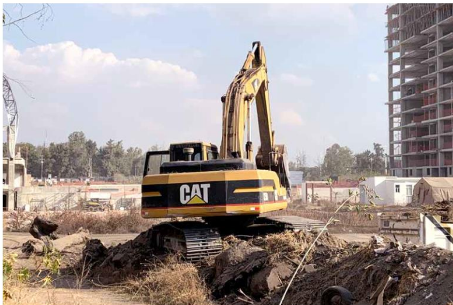
EN CONSTRUCCIÓN. Este miércoles NTR visitó el predio donde se ubicará Iconia y detectó que hay varias obras en proceso.
