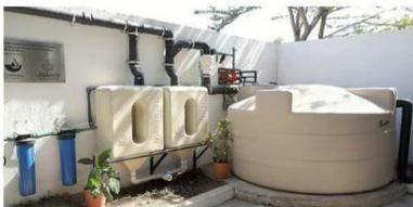
■ El sistema consiste en la conexión del techo para canalizar la lluvia hacia un almacenaje, donde se filtra y se convierte en agua potable.
