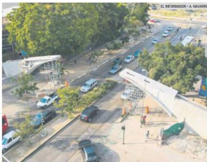
INSTALACIÓN EN EL PASEO ALCALDE. El puente nuevo no será peatonal, sino una réplica del que llevó a cabo el arquitecto Raúl Gómez Tremari.
