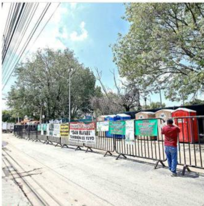
■ El Parque San Rafael, donde se construía un colector pluvial, amaneció ayer con sellos de clausura de la Procuraduría Federal de Protección al Ambiente.
