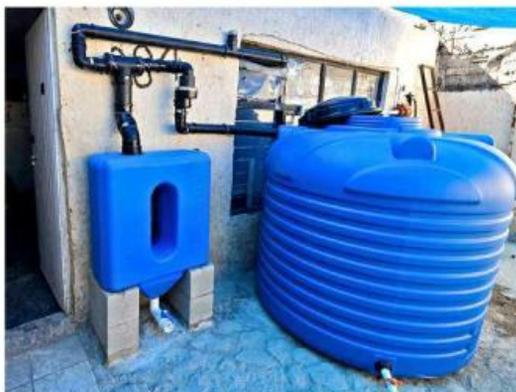
El proyecto de Nidos de Lluvia consiste en colocar sistemas de captación de agua pluvial.
