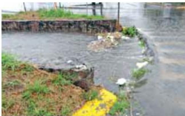
Trabajos. Hay labores de limpieza de las calles. / GOB DE TLAJOMULCO
