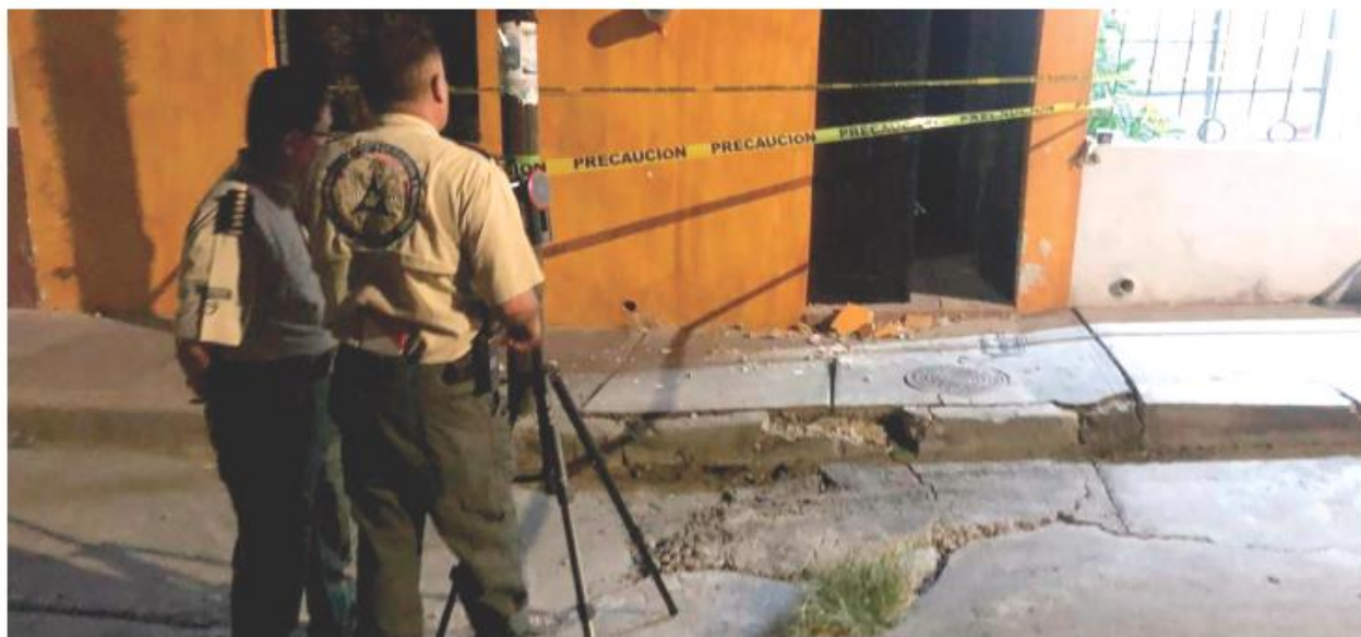
Autoridades continúan realizando varias labores de supervisión para decaer más daños.
