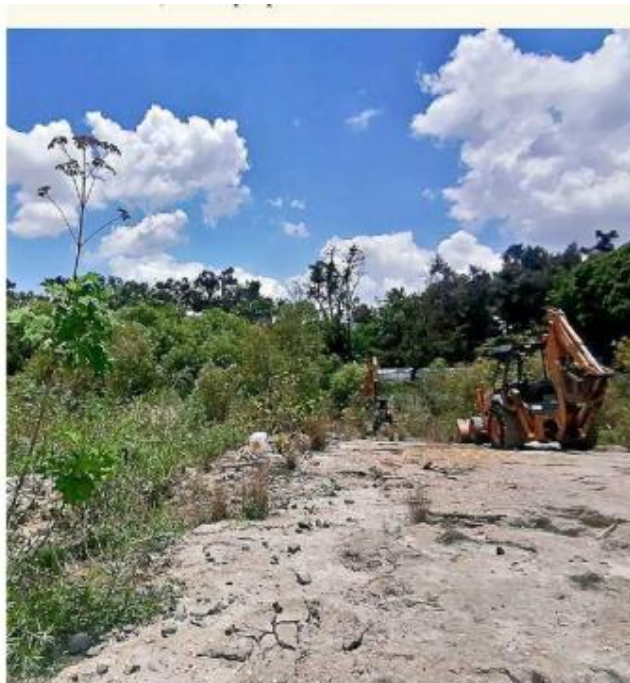
■ La construcción del colector pluvial San Rafael costará alrededor de 67.5 millones de pesos.
