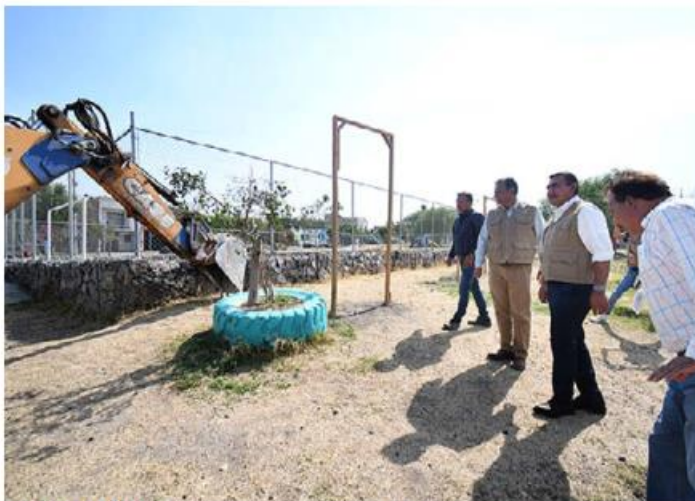
AMPLIACIÓN. Esta semana inició la construcción de una cancha de fútbol rápido en las inmediaciones del LabASE de Tlajomulco, con una inversión de más de un millón de pesos.
