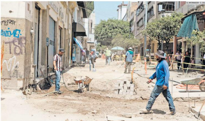
ZONA PEATONAL. Los trabajos en el andador Pedro Moreno contribuirán a mejorar el Centro Histórico.
