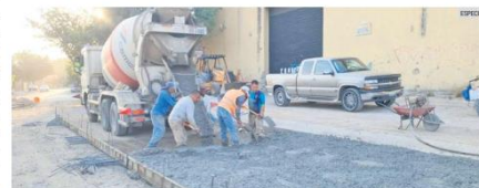
PROCESO. Otro proyecto en construcción se realiza en el Alamo Industrial.
