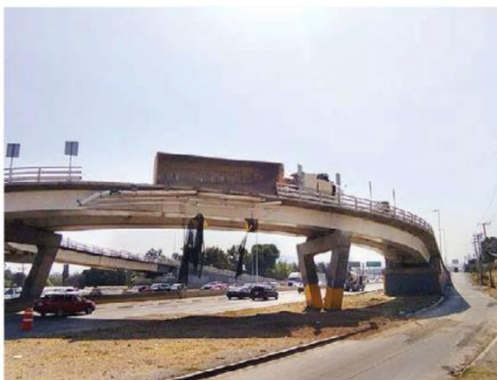
VOLCADURA. Un tráiler con 42 toneladas de arena se volcó sobre el paso elevado ubicado en Periférico Sur, a la altura de Toluquilla, lo que provocó el cierre de dicha vía por más de seis horas.
