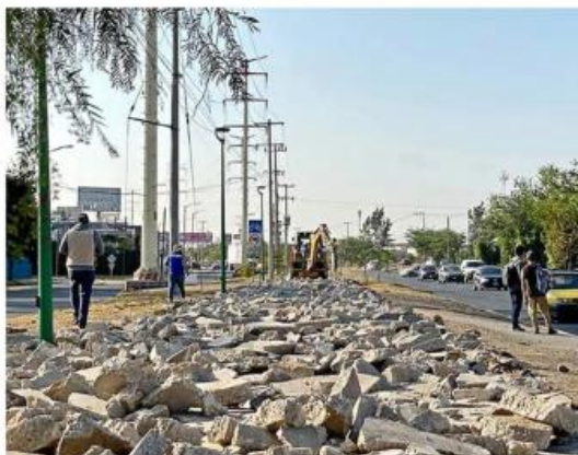
■ En Adolf Horn y las vías del tren se realiza un nodo vial, que será parte del proyecto de la Línea 4.
