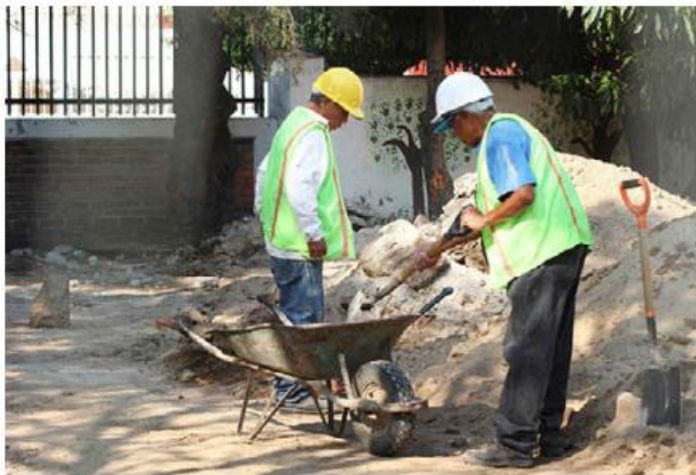
OBRAS. Ayer arrancó la renovación de la primaria Narciso Basols, en Zapopan. La obra, con una inversión de 3 millones de pesos, incluye la construcción de una cancha de usos múltiples.
