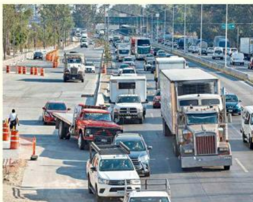
■ En torno a Ciudad Judicial falta la remoción de cableado, hay tambos naranjas que advierten de las obras.
