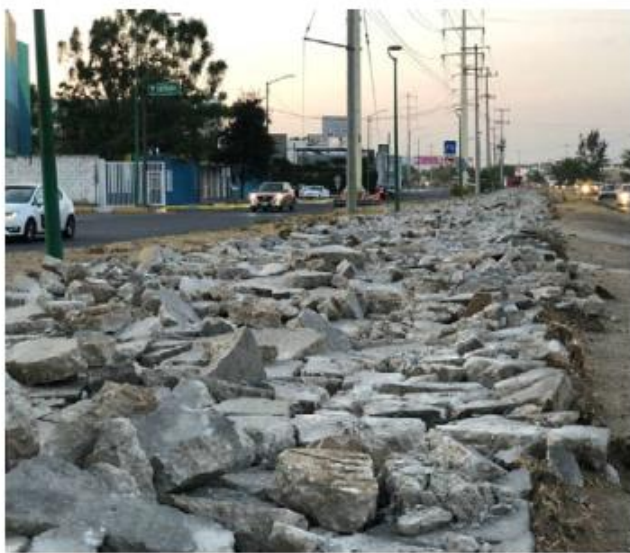
Los trabajos iniciaron en la avenida Adolf Horn. R. ÁLVAREZ
