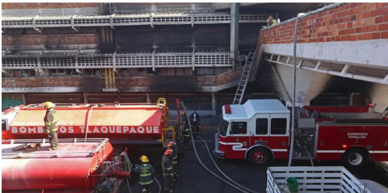
El pasado 31 de marzo se registró el incendio en el Mercado Libertad que causó daños en los cuatro niveles. FERNANDO CARRANZA
