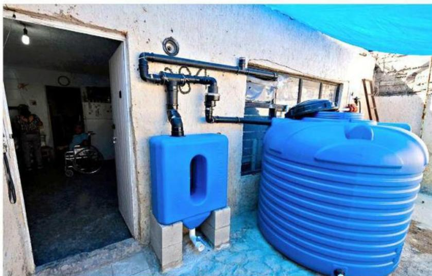
El sistema consiste en la conexión del techo de la vivienda para canalizar el agua de lluvia hacia un almacenaje.
