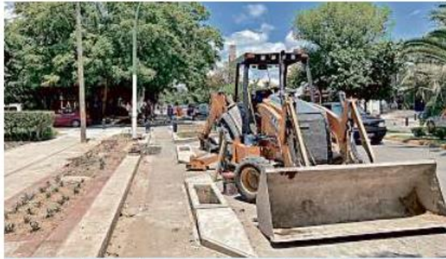
■ Los trabajos incluyen ciclovía y ampliación de banquetas.
