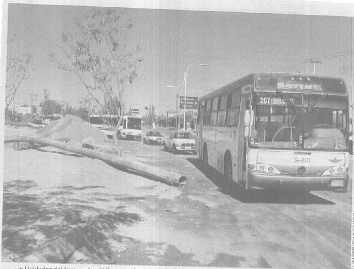
• Unidades del transporte público y vehículos particulares deben rodear la Central Camionera para sortear los trabajos de pavimentación.
