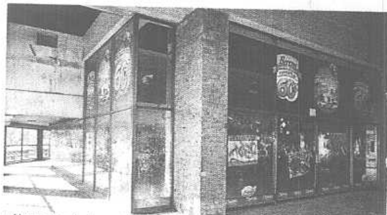
> Algunos locales lucen abandonados y en mal estado, dando pie a ser guarida de delincuentes o indigentes que rondan por la zona.
