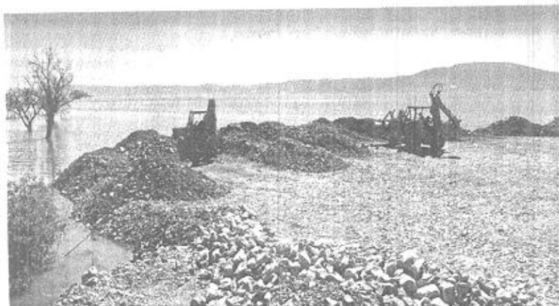
Las obras en márgenes del lago incluan movimientos de tierra y derribo de arbolado.
