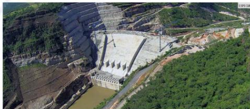
POLEMICA. Desde 2015, así luce la Presa El Zapotillo.
