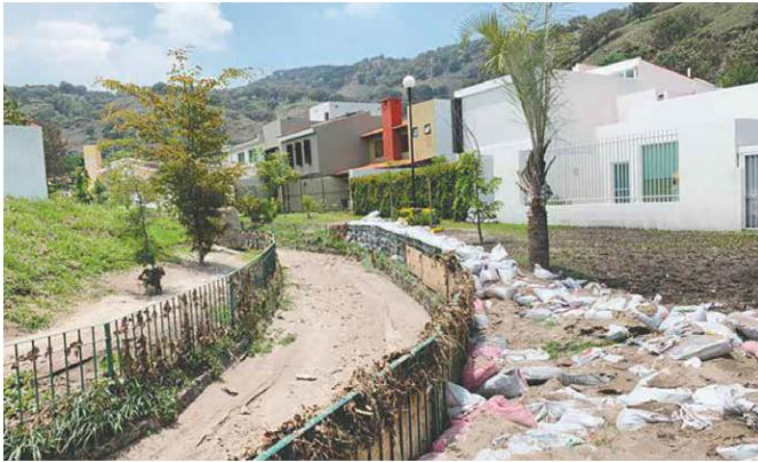
PANORAMA. Las inundaciones registradas en Bosques de Santa Anita han sido una demostración de los peligros para futuros desarrollos.
